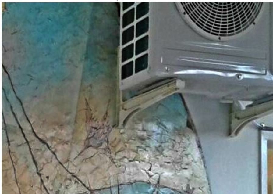
Figura 5 – Detalhe do mural da E. M. Edgar Monteiro Castanheira
