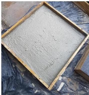
**Figura 2:** Exemplo de ponte de aderência entre a base e o contrapiso realizada com pasta de cimento.
