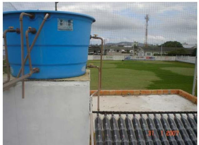
Figura 2 - Aquecedor ligado à caixa.
