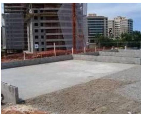
Figura 4 - Baias de agregado reciclado
